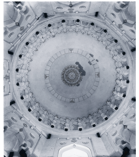
写真4. デカンのジャーマ・マスジド（グルバルガ、1367年） キブラ側に設けられた大ドーム室を下から撮影。直径9.5メートルのドームが8つのアーチによって支えられ、ドームの周囲を24個の小アーチが取り囲んでいる。
