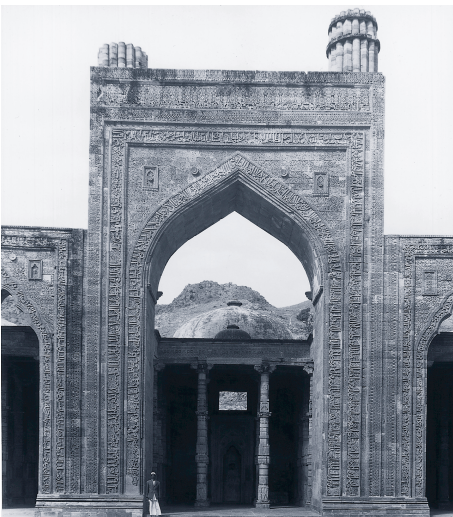
写真1. アジメールのアライ・ディン・カ・ジョンブラ・モスク（1210年） インドで2番目に古いモスクで、ヒンドゥー転用柱で作られた礼拝室の前に分厚いアーチ壁が立つ。ただしアーチは水平材を積み重ねた擬似アーチである。
