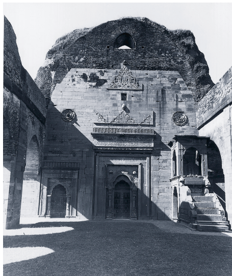
写真3. ベンガルのアディナ・マスジド（1374-5年） 巨大な中庭のキブラ側中央に位置するイワーンで、間口9.8メートル奥行19.5メートル。本来はトンネル型の屋根を頂いていた。奥にミフラーブとミンバルが見える。
