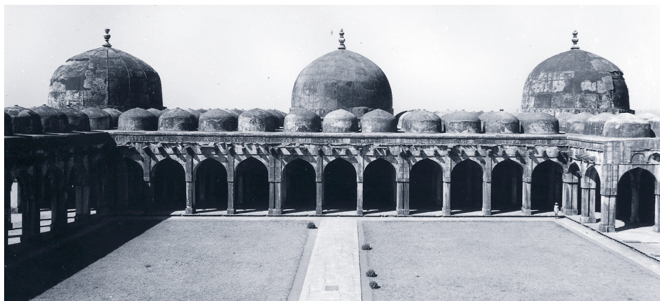
写真7. マルワ地方のジャーマ・マスジド（マンドゥー、1454年） 入口からキブラ方向を撮影。小ドームと小ドーム9つ分の大ドームから構成され、中庭は等間隔のアーケードによって囲まれる。
