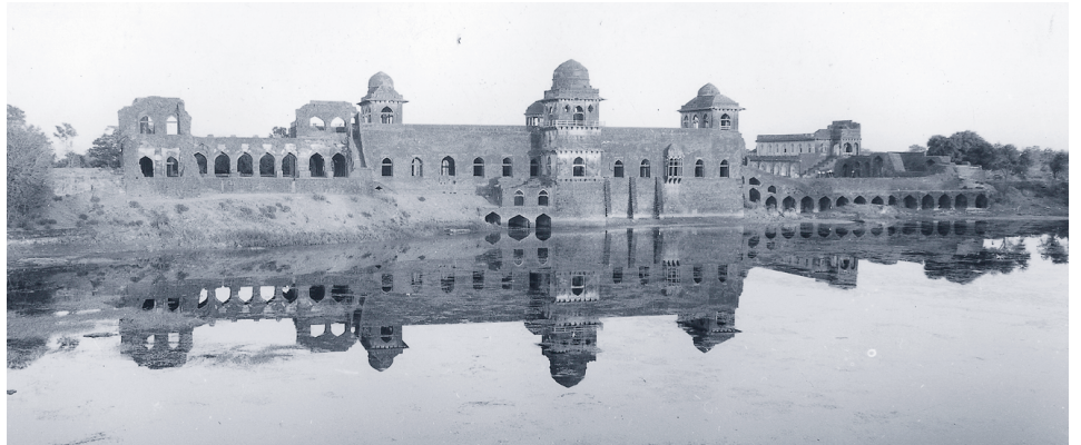
写真2. マンドゥーのジャハーズ・マハル（15世紀後半） 船の宮殿の名を持ち、大きな池に挟まれる。2層の建築で、上層には形の異なるパヴィリオンが配される。
