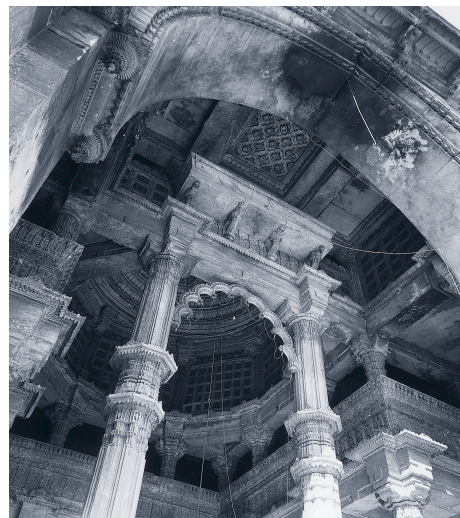
写真5. グジャラートのジャーマ・マスジド（アフマダーバード、1423年） 分厚いアーチ壁の背後に作られた梁柱式の中央ドーム。柱を3層分積み重ね、直径は5メートルと小振りながら高さ14メートルのドーム空間を創出する。
