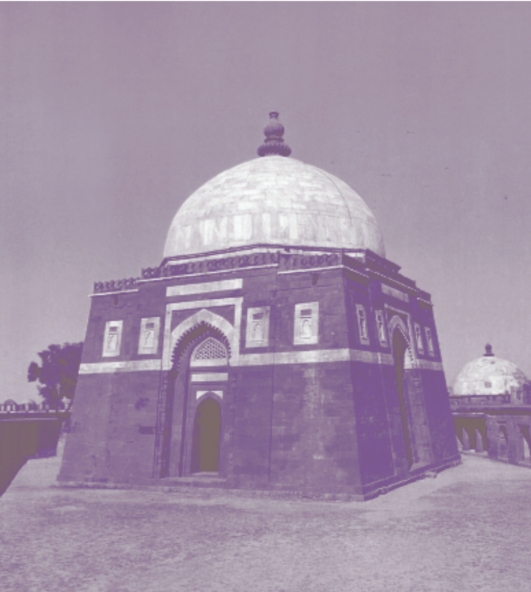
ギヤースッディーン・トゥグルクの墓 ギヤースッディーン・トゥグルク（1325年没）はデリー諸王朝の一つトゥグルク朝の創始者。14世紀前半の建設で、傾斜した赤砂岩の壁面の上に、白大理石のドームをいただく。東京大学インド史跡調査団（1959-62年）撮影。
